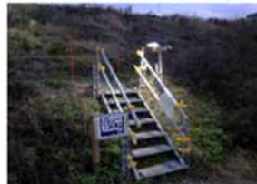
人感センサー付きライト設置例(見える安全活動コンクールより)
